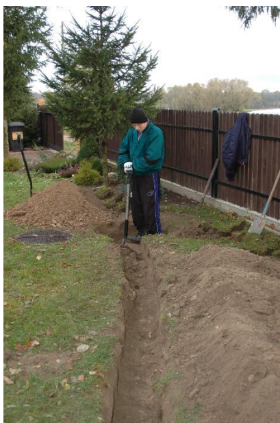
figura 3. Scavo manuale per tubi
