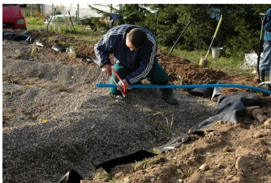
Figura 2. Collegamento del serbatoio del colono al drenaggio infiltrato
