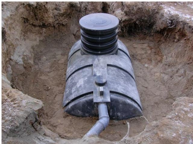
Figura 2. Stazione di pompaggio nello scavo
