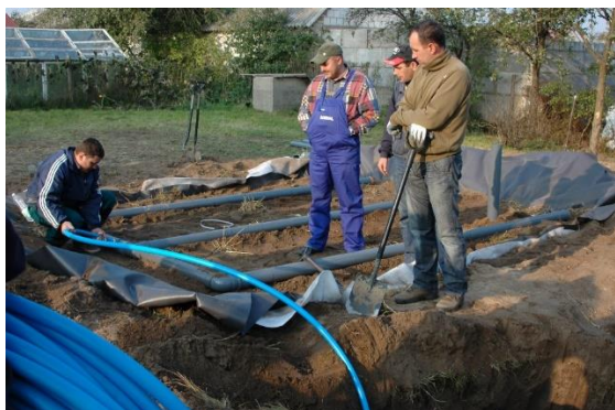
Figura 2. Collegamento del serbatoio del colono al drenaggio infiltrato
