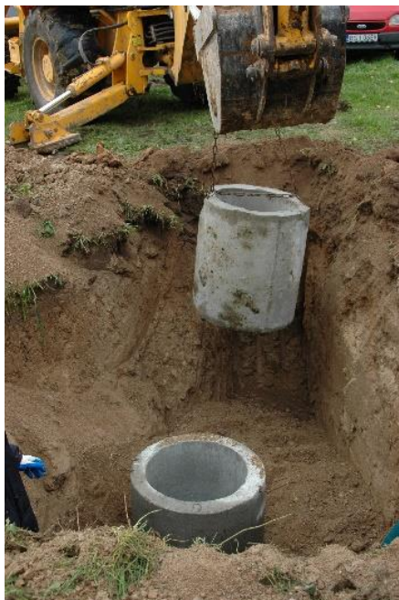
figura 3. Installazione di un pozzo assorbente
