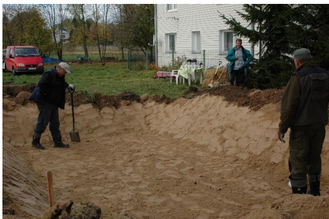
Figura 4. Rendere il primo strato del filtro – sabbia per la pellicola.
