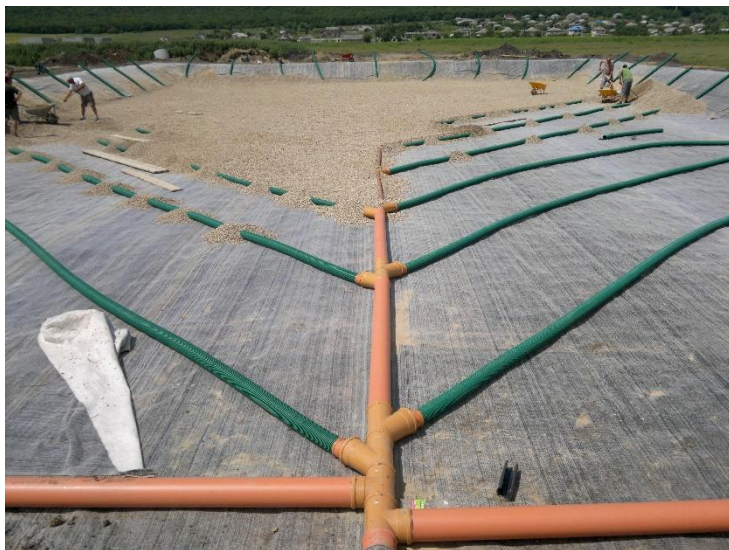
Figura 9. Riempimento dello scarico di raccolta
