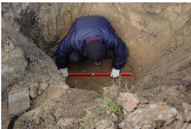
Figura 5. Livellamento del fondo dello scavo
