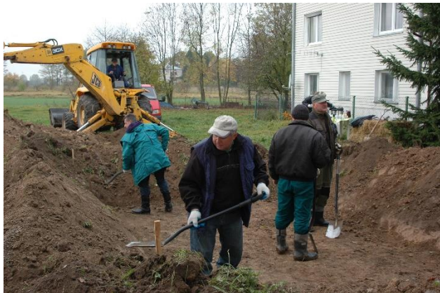
Figura 2. Scavi per un filtro di sabbia
